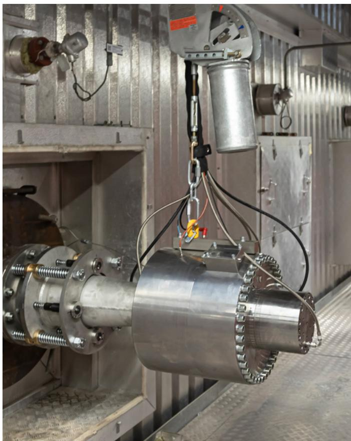
Die neue Serie des Shock Pulse Generatoren, angeschlossen an einen Kessel zur Online-Reinigung.
